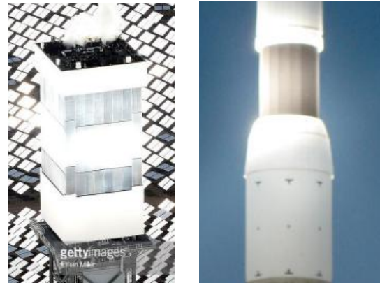
图 3 国外光热电站吸热器运行照片
