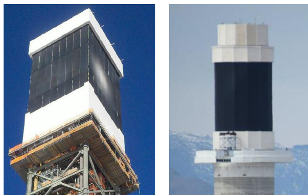
图2 国外已投运光热电站吸热器
