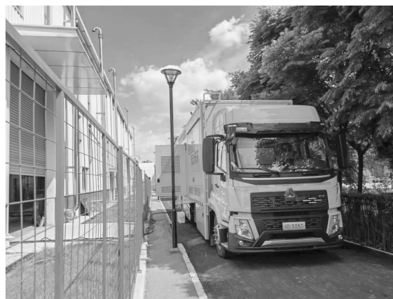
图 7 氢燃料电池保供车电源现场工作调试
